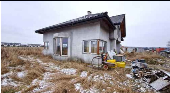
Strona wschodnia – garaż i boczne wejście do budynku
